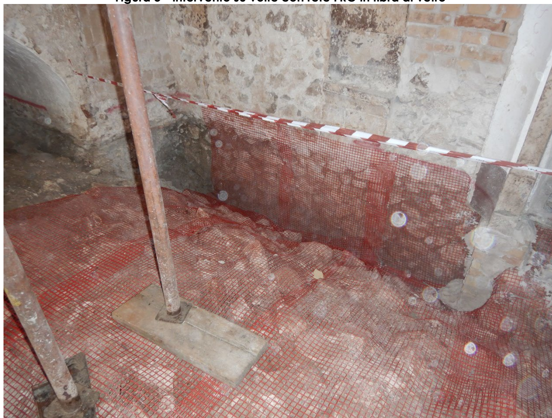
Figura 4- intervento su volte con rete FRG in fibra di vetro
