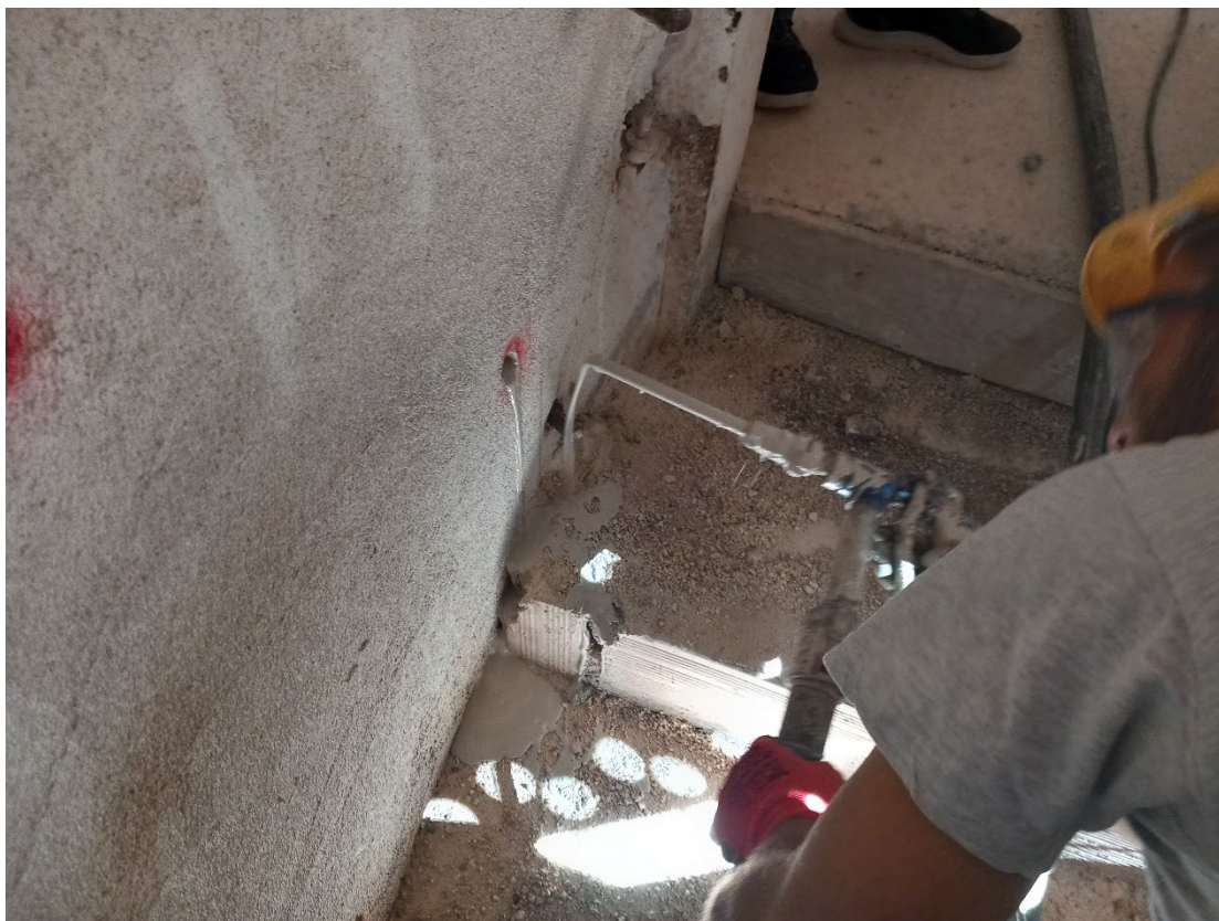
Figura 45 - iniezioni in paramenti murari
