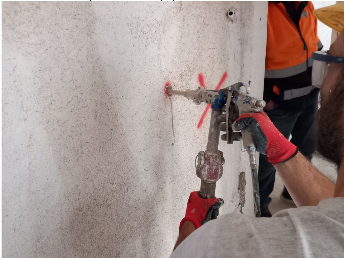
Figura 44 – iniezioni di malta in paramenti murari
