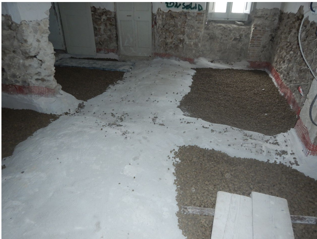
Figura 5- intervento su volte con rete FRG in fibra di vetro - riempimento
