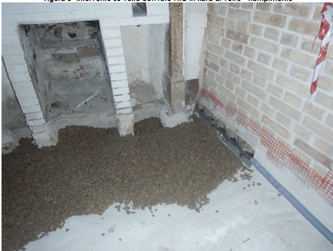
Figura 6- intervento su volte con rete FRG in fibra di vetro - riempimento e inserimento catena in acciaio
