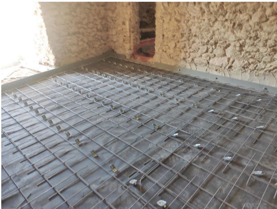
Figura 27 - nuovi solai lignei con connettori
