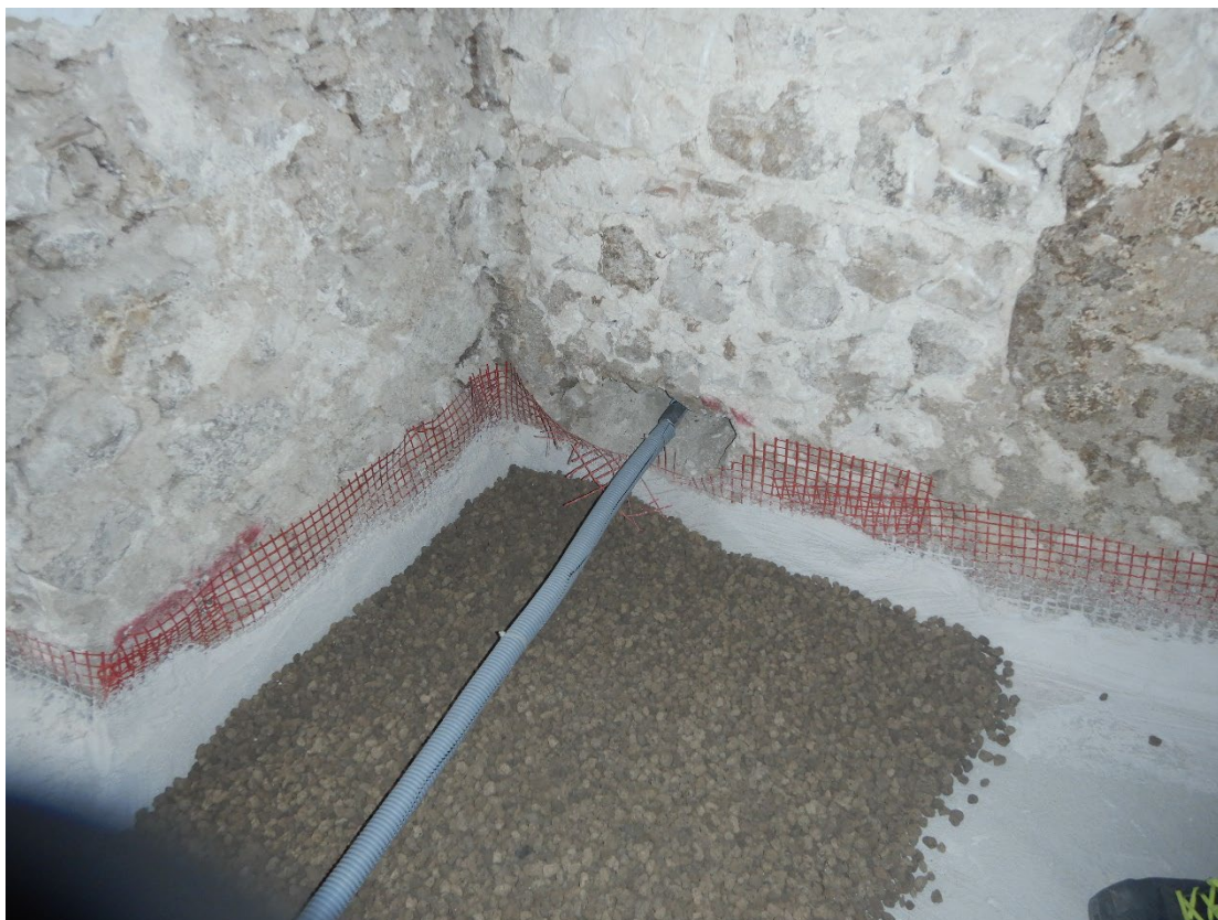
Figura 7 – inserimento catena in acciaio
