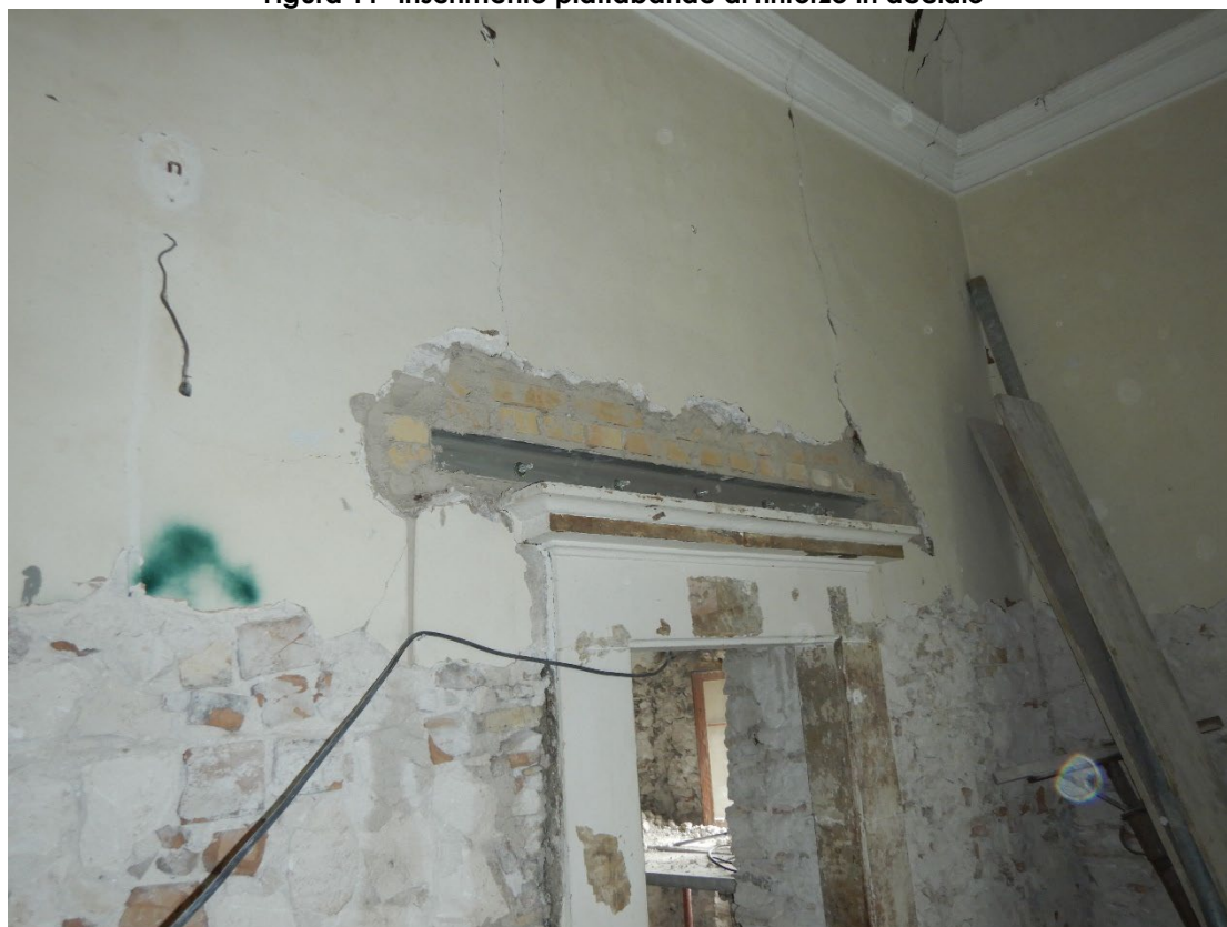
Figura 12- inserimento piattabande di rinforzo in acciaio
