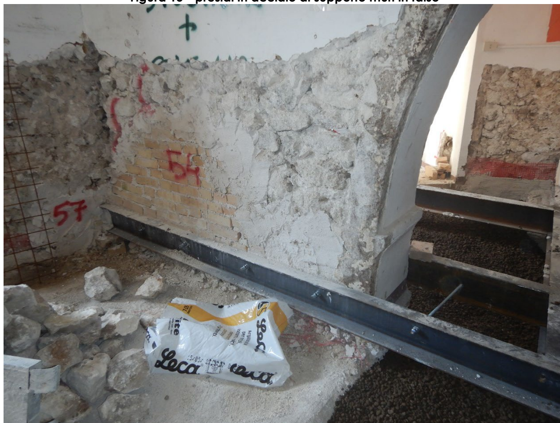
Figura 16 – presidi in acciaio di supporto muri in falso
