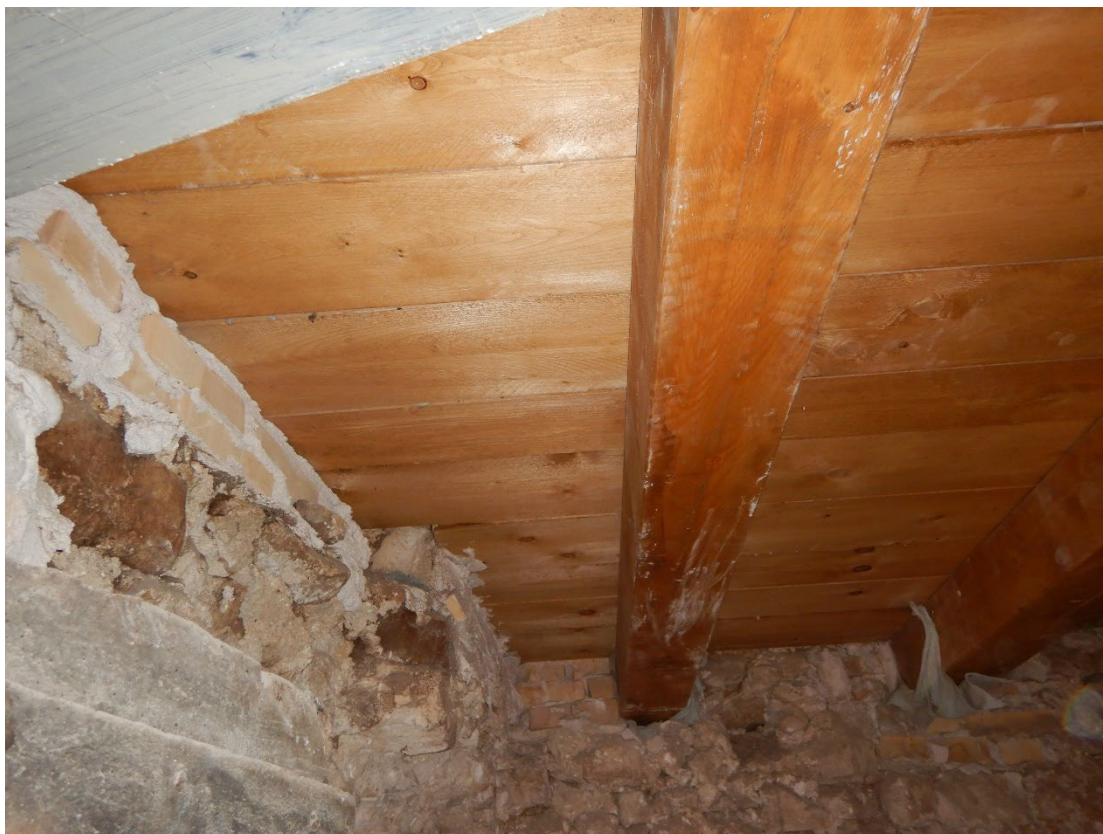
Figura 29 - nuovi solai lignei
