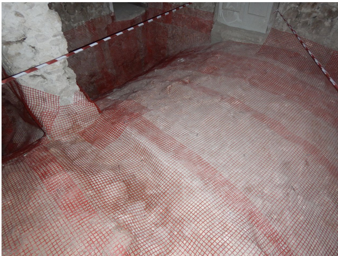
Figura 1 - intervento su volte con rete FRG in fibra di vetro
