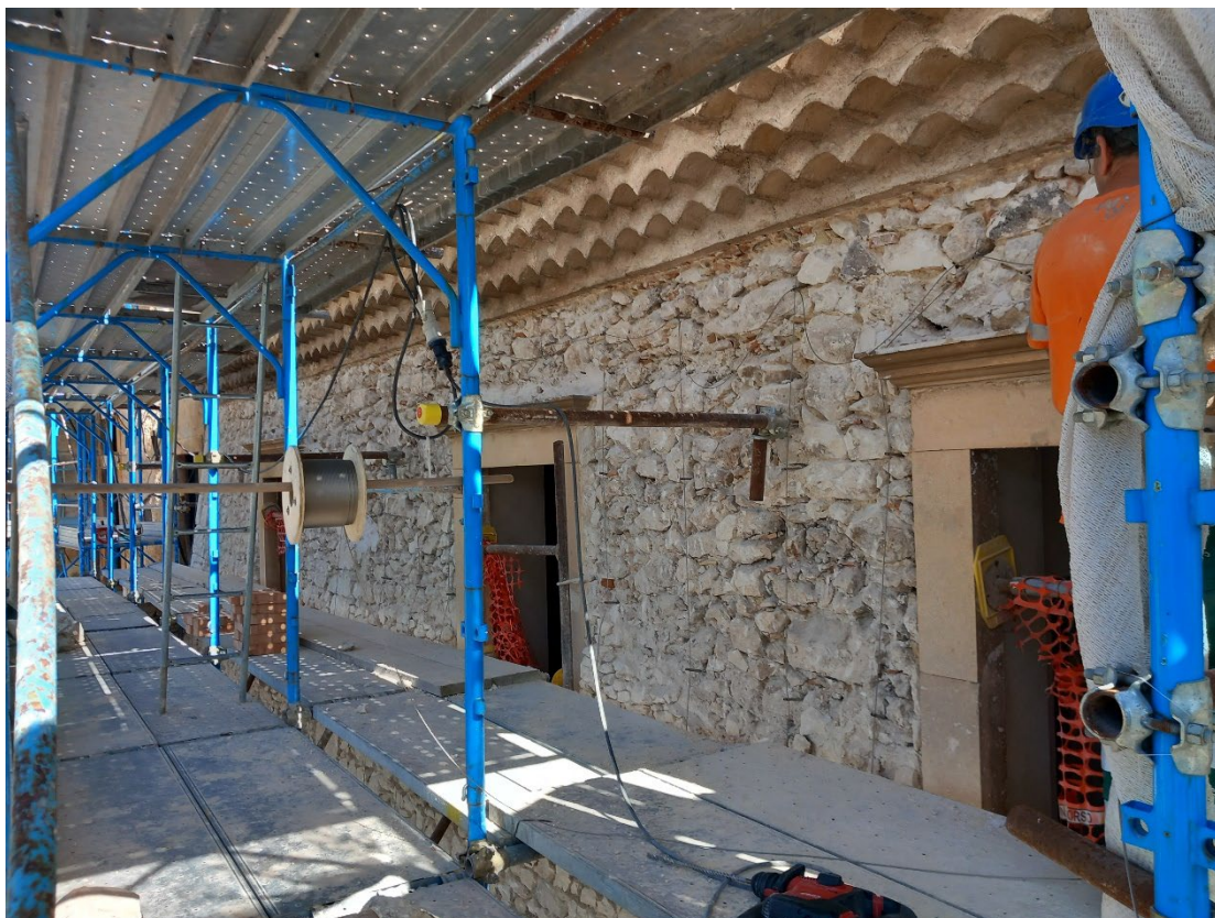
Figura 37 - realizzazione rafforzamento paramenti murari a vista – lato esterno a "reticolatus"
