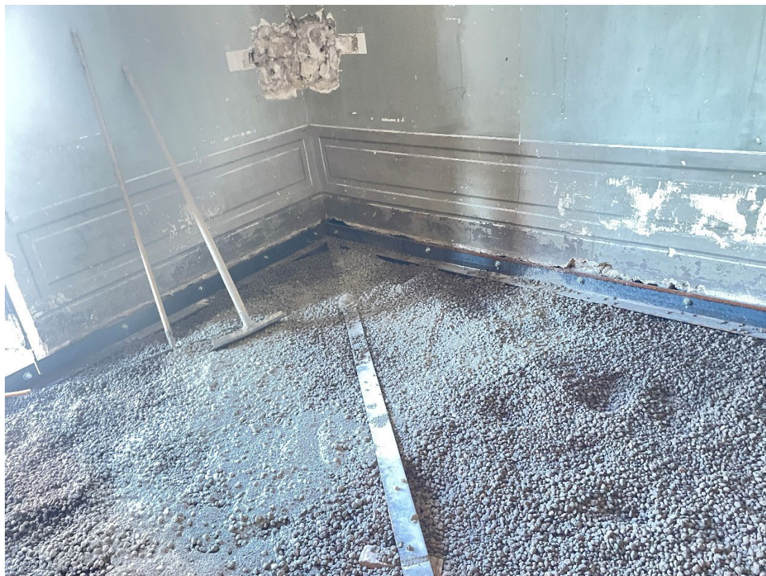
Figura 23 - cerchiatura solai e riempimento
