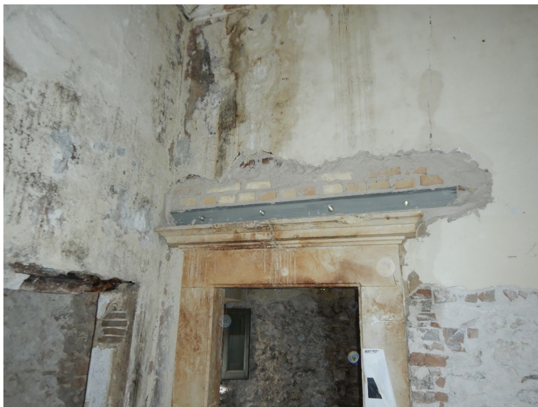
Figura 11- inserimento piattabande di rinforzo in acciaio
