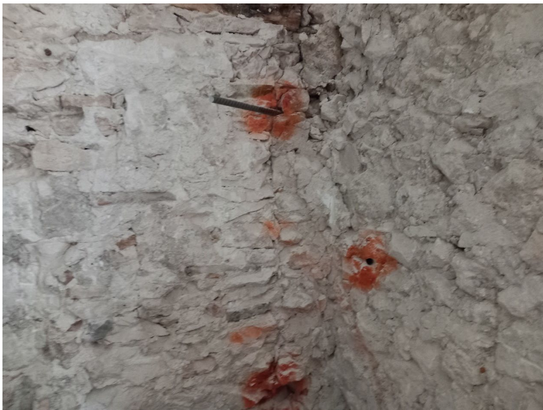
Figura 47 - rafforzamento incroci con cuciture armate tramite barre in acciaio diam 20 ad adherenza migliorata
