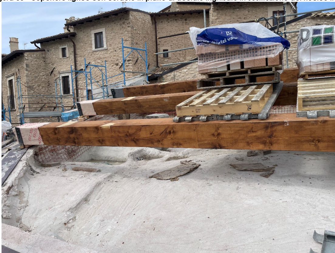
Figura 34 - coperture lignee con cordolo in piatto di acciaio inghisato in sostituzione del nucleo in cls
