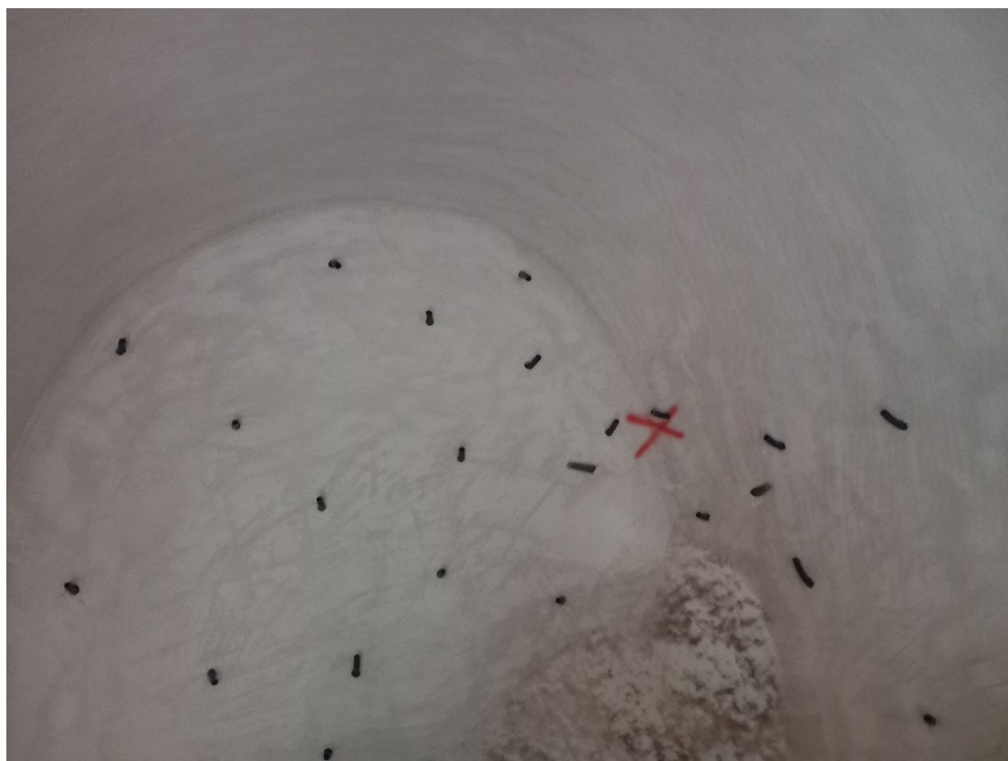
Figura 39 – iniezioni di malta in paramenti murari - preparazione
