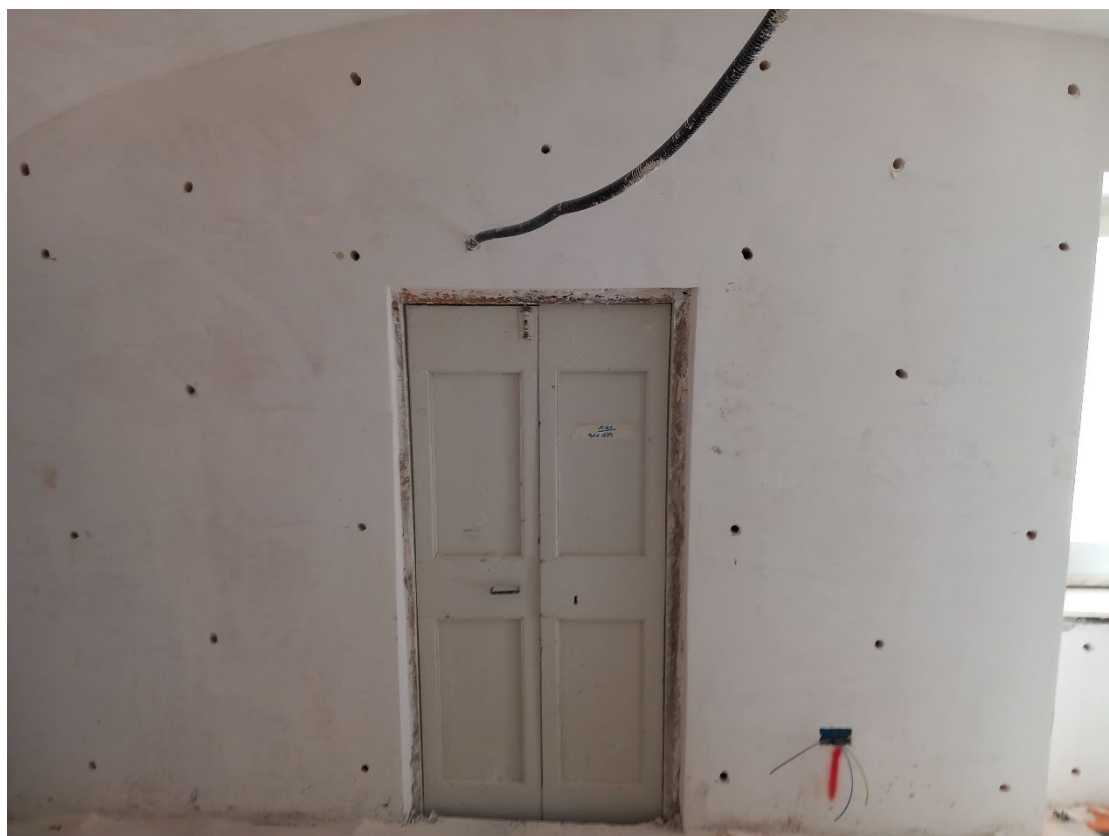
Figura 41 - iniezioni di malta in paramenti murari - preparazione
