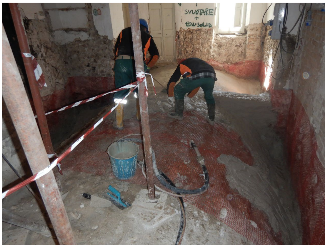
Figura 3 - intervento su volte con rete FRG in fibra di vetro
