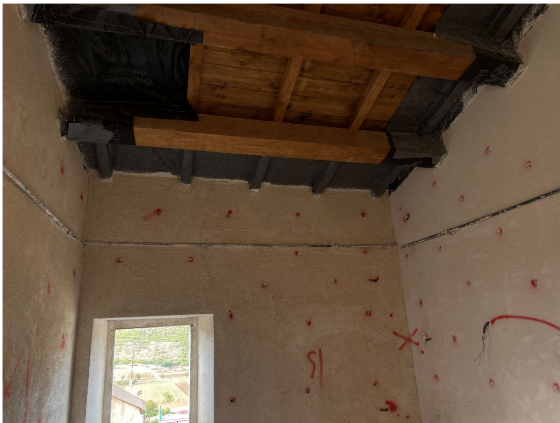
Figura 43 – iniezioni di malta in paramenti murari – preparazione e rafforzamento incroci con barre in acciaio
