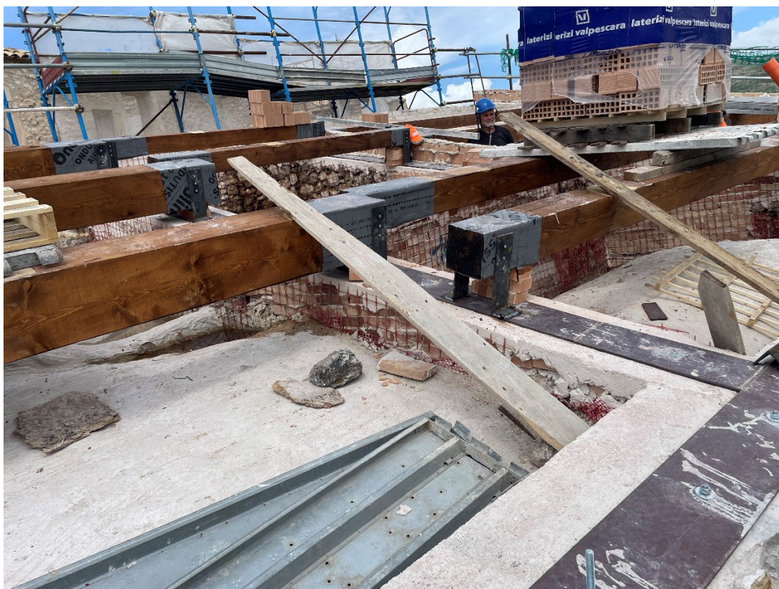
Figura 33 - coperture lignee con cordolo in piatto di acciaio inghisato in sostituzione del nucleo in cls
