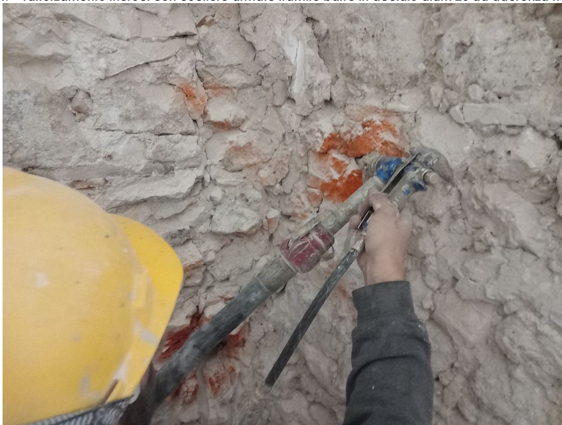
Figura 48 - rafforzamento incroci con cuciture armate tramite barre in acciaio diam 20 ad adherenza migliorata
