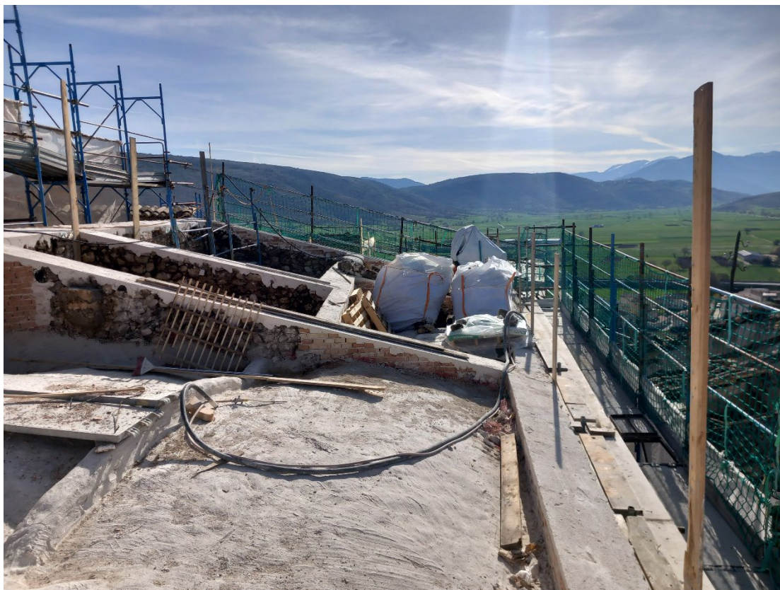
Figura 31- preparazione appoggi coperture
