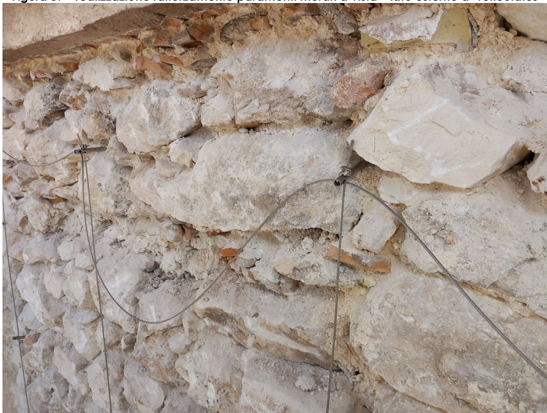
Figura 38 - realizzazione rafforzamento paramenti murari a vista – lato esterno a "reticolatus"
