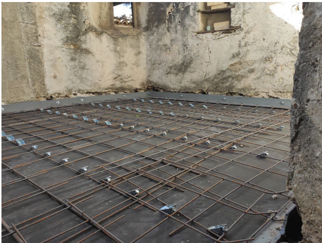
Figura 25 - nuovi solai lignei con connettori
