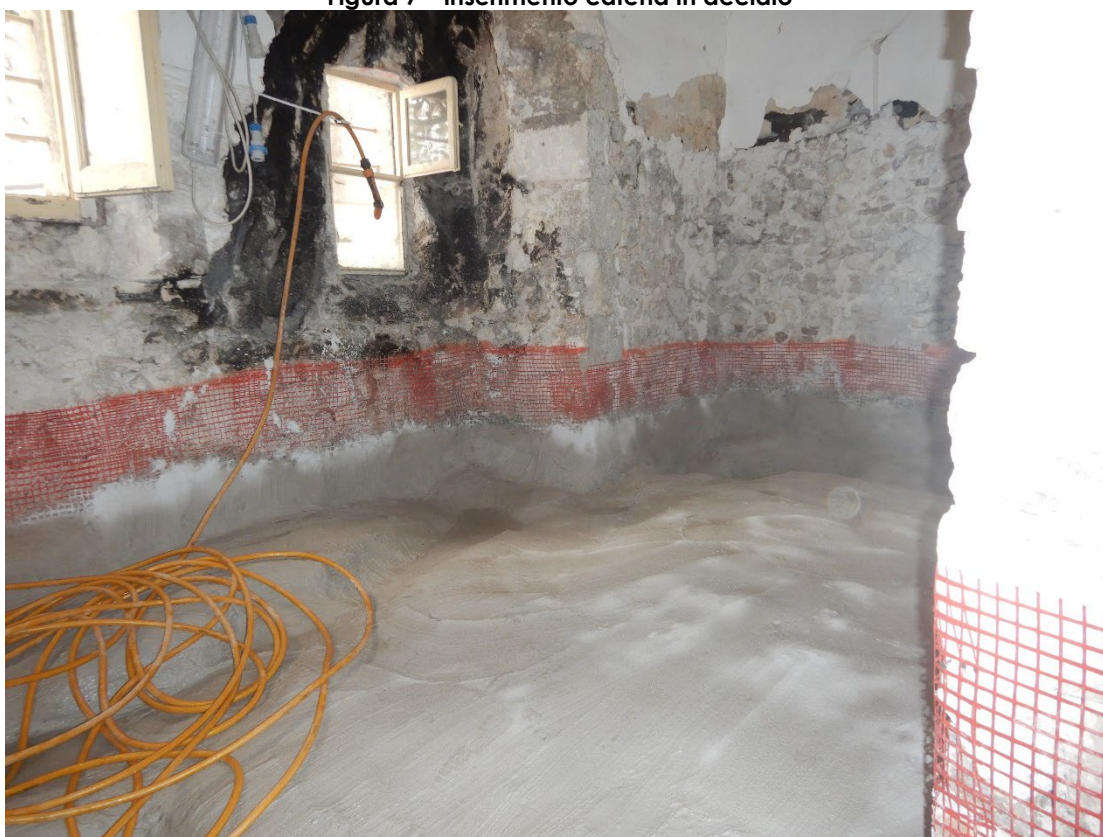
Figura 8- intervento su volte con rete FRG in fibra di vetro - riempimento completato
