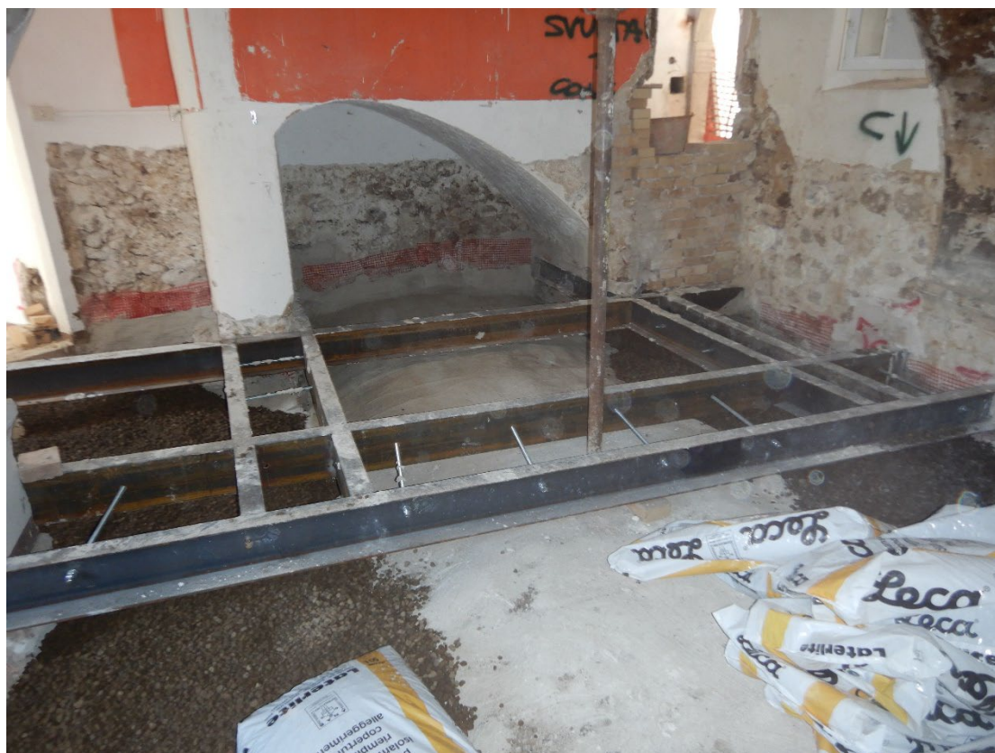
Figura 15 - presidi in acciaio di supporto muri in falso
