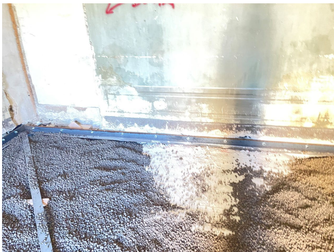
Figura 24 - cerchiatura solai e riempimento
